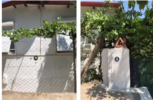
Şekil 3. Nazarköy’de bir evin dış cephesinde duvara gömülmüş nazar boncuğu (Yazar arşivi, 2024)
