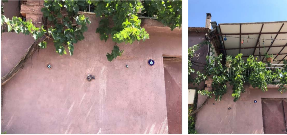
Şekil 5. Nazarköy’de bir evin dış cephesinde duvara gömülmüş nazar boncuğu (Yazar arşivi, 2024)
