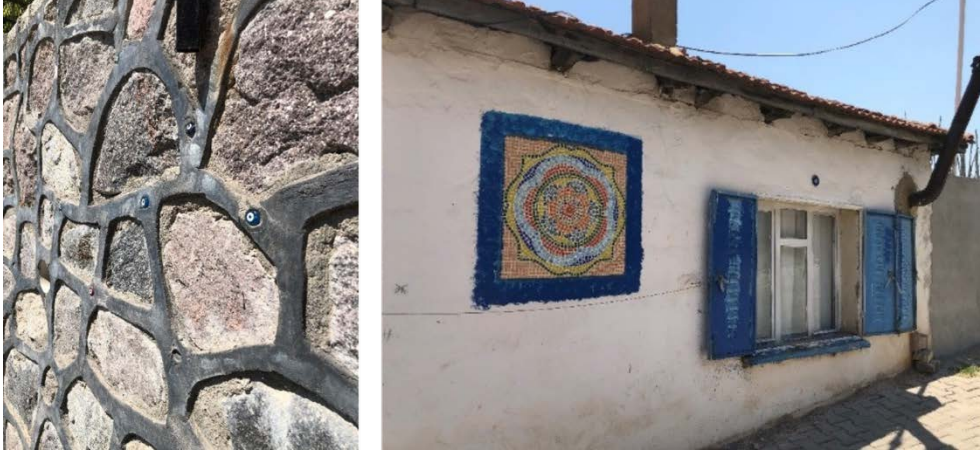
Şekil 4. Nazarköy’de bir evin dış cephesinde duvara gömülmüş nazar boncuğu (Yazar arşivi, 2024)
